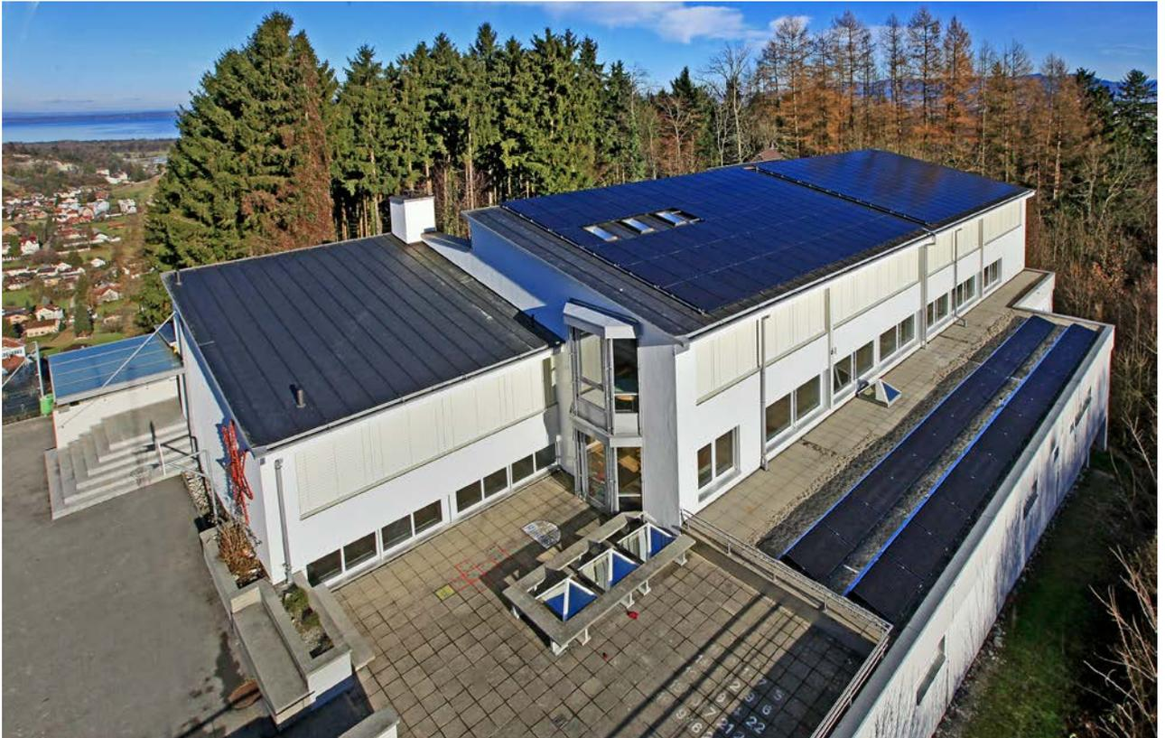
Photovoltaikanlage auf dem Schulhausdach
