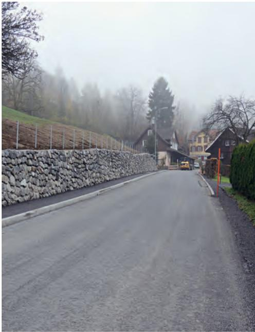
Vom Einlenker Seeblick in Richtung Tolen ist die neue Vorgrund-Steinmauer zu sehen, die den Hang sichert, der abgetragen werden musste. Vor der Mauer sichtbar ist das neue Trottoir, das im nächsten Jahr noch mit dem Deckbelag versehen wird.
