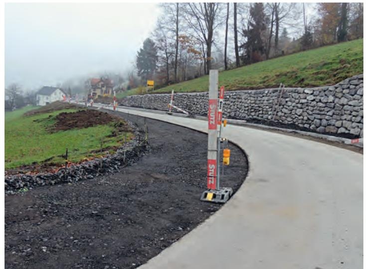
Der Blick vom Durchlass des Krennenbachs aus in Richtung Tolen zeigt links den dunklen Untergrund, auf dem die Strassenbreite noch erweitert wird. Im Bild rechts ist die Hangsicherung zu sehen, die aus einer Vorgrund-Steinmauer besteht.
