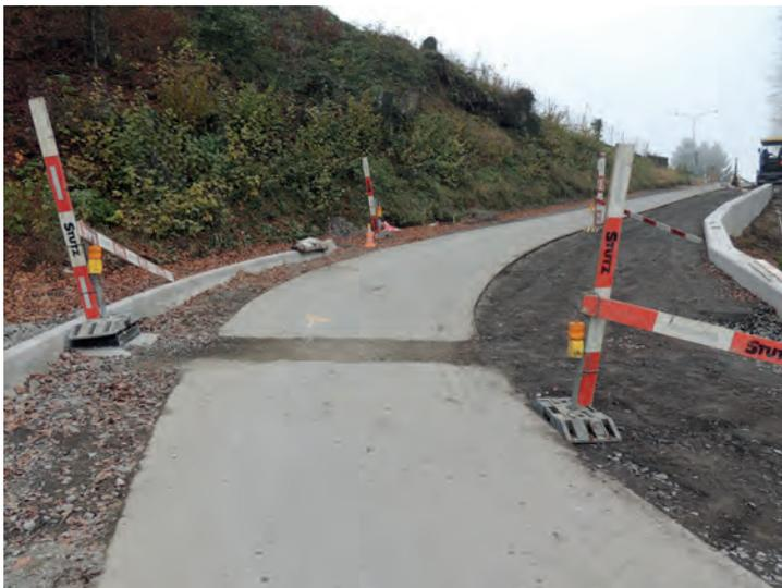
Talseitig wurden ab dem Einlenker zur Hauptstrasse Grub–Rorschach sowie beim Durchlass des Krennenbachs reine Beton-Stützmauern erstellt.
