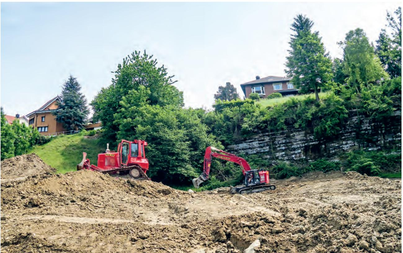
Der Trax und der Bagger verteilen das Erdmaterial nach genauen Planvorgaben, bevor sie den Humus auftragen.
