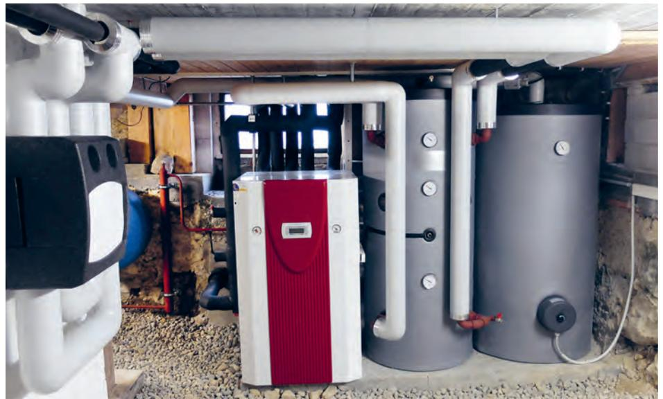
Wärmepumpen wandeln die Umweltwärme tieferer Temperatur in Heizwärme höherer Temperatur um. Das Bild zeigt eine Wärmepumpe, die Erdwärme mit Hilfe einer Erdsonde nutzt.
