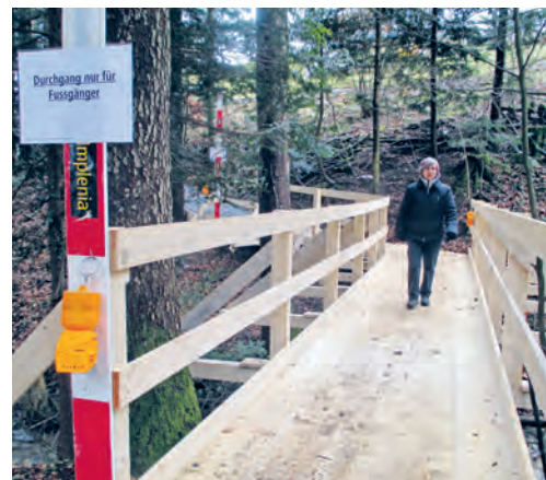
Der Eichenbach kann bis Oktober 2018 nur mittels einer Fussgängerbrücke überquert werden.
