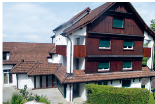
Die ehemalige Kurhausliegenschaft <Seeblick>
