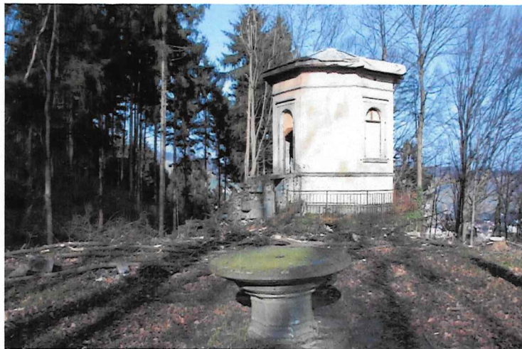
Zustand 2002: Aussen- und Innenaufnahme
